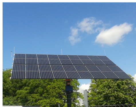
Figur 5. Solföljare. En solföljare följer solen och riktar in sig så att infallsvinkeln alltid är den bästa. Foto: Sven Nimmermark
