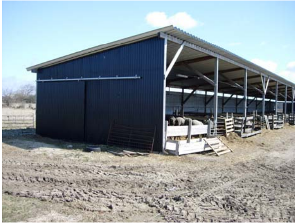
Öppen byggnad med stolpkonstruktion
