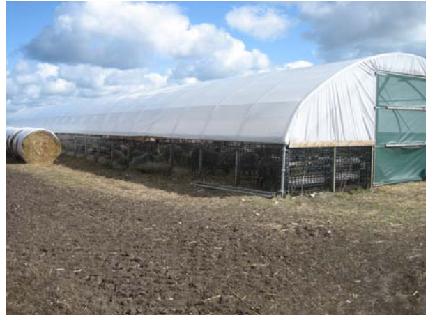
Bågkonstruktion med plastfolie
