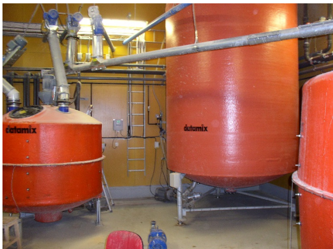
Bild 3. Utfodringstank för tillväxtgrisar till vänster och en stor fermenteringstank för spannmål till höger om utfodringstanken (Gård B).
