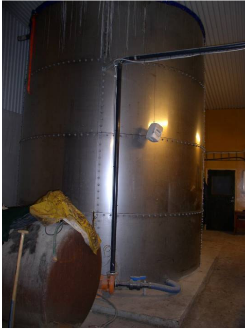
Bild 4. Stående lagringstank för vassel/dränk med propeller i botten för omröring.
