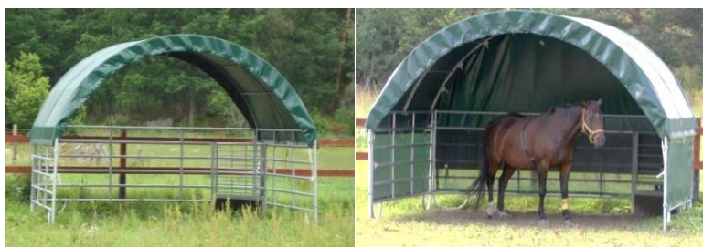
Figur 2. Öppet skydd med plasttak till vänster, och stängt skydd med vindgenomsläpplig plast på två sidor och plastad baksida till höger.
