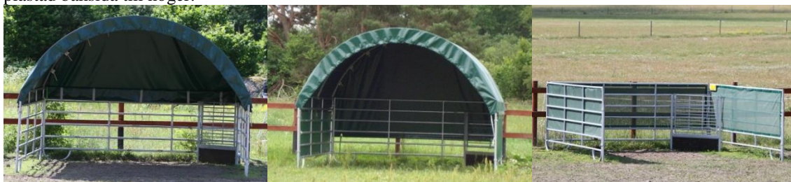
Figur 3. Till vänster öppet skydd med plasttak och ogenomskinlig plastad baksida. I mitten stängt skydd med tak, ogenomskinlig plastad baksida och vindgenomsläpplig plast på två sidor. Till höger öppet skydd med vindgenomsläpplig plast på tre sidor. Skydden var 4 m x 4 m x 3.15 m (Mobile Covers®, Tyskland).
