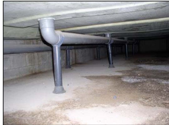
Bild 2: Kanaler under stallet
